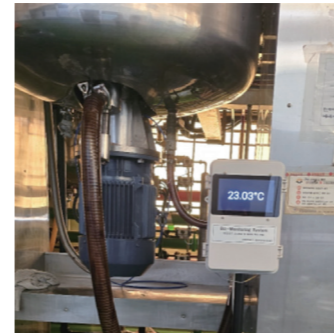
온도 데이터 로거 설치 모습
